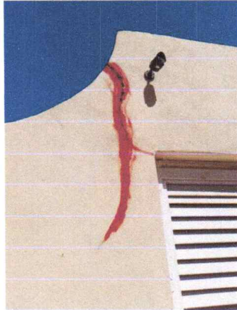
Pretil área de gas
