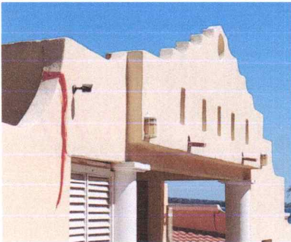
Pretil en cochera techada
