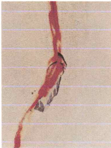
Falla al exterior
