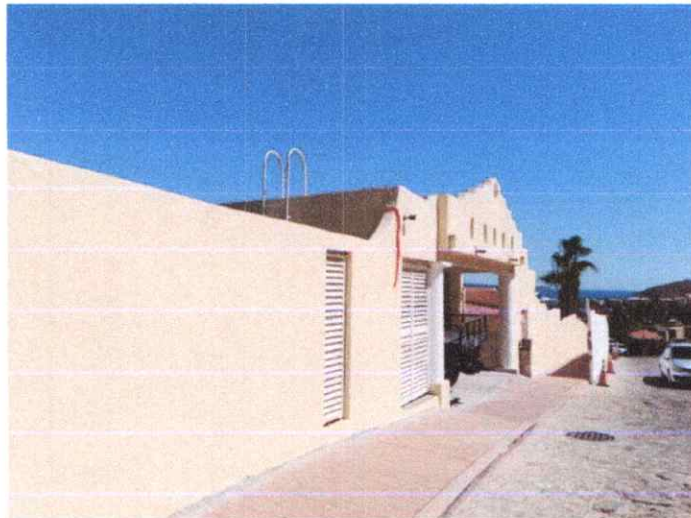
Fachada principal del Inmueble
