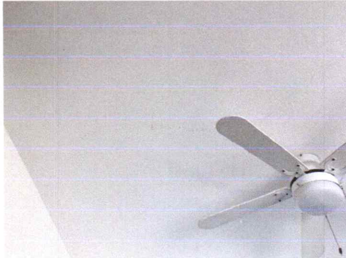
Plafón de yeso en recámara 4
