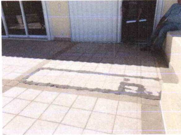
Piso de terraza con emulsión asfáltica
